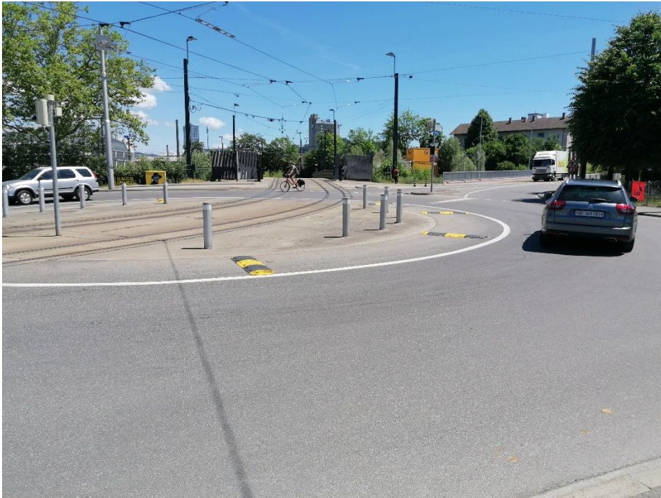
Beispiel Sofortmassnahme Temporeduktion Mingerkreisel Bern (Foto: Florian Boller, 27.5.2022)
